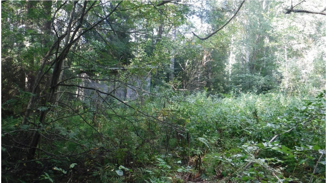
Kuva 13: Häntämäen luodepuolella on vanha vedenottamo, jonka ympäristö on rehevää. Kuvassa on vanha vedenottamorakennus.
